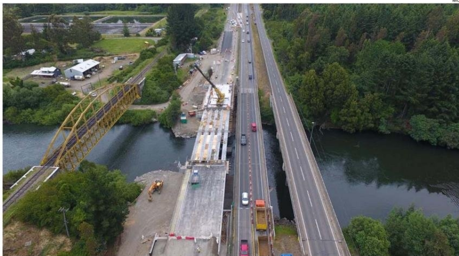
EL PUENTE TIENE CIENTO METROS DE LARGO Y SE CONSTRUYE DE ACUERDO A LA NORMATIVA SÍSMICA ACTUAL.
