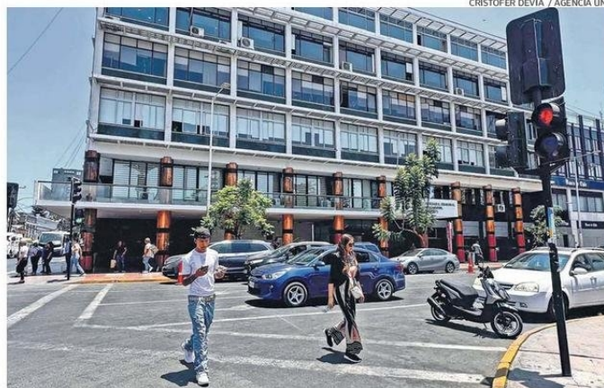
EL EDIFICIO QUE ALBERGA A LA DPR Y AL GORE CUENTA CON SERIOS PROBLEMAS DE INFRAESTRUCTURA.
