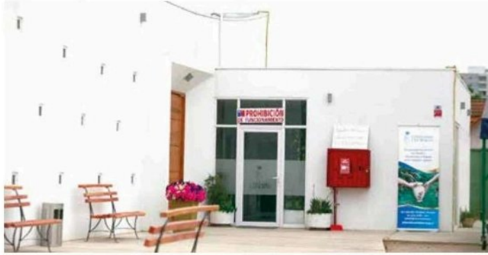
El crematorio cuenta con chimeneas ubicadas a 20 metros de viviendas, las cuales se encuentran a la misma altura de los segundos pisos las casas del sector.
