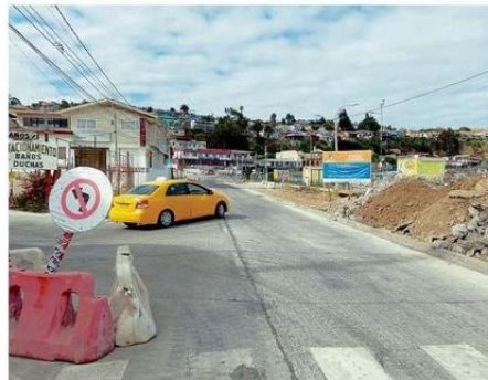
DESVÍOS DE TRÁNSITO Y ESCOMBROS EN PLENA PLAYA CHICA.
