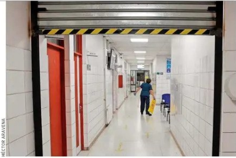
Durante las noches, el Cesfam cierra con cortinas de hierro los sectores que no son utilizados, para evitar robos.
