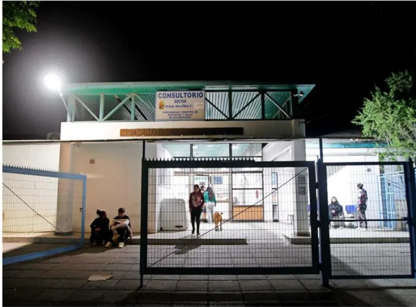
El recinto debió ser enrejado en todo su perímetro, más instalación de cámaras con sensores de movimiento y puertas blindadas.
