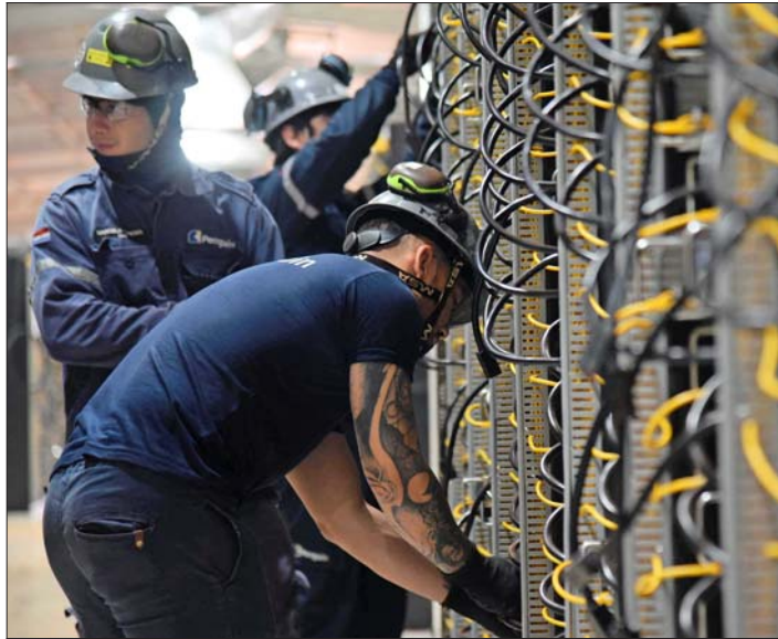
El Ministerio de Ciencia presentó ayer el “Plan Nacional de Data Centers 2024-2030”.
