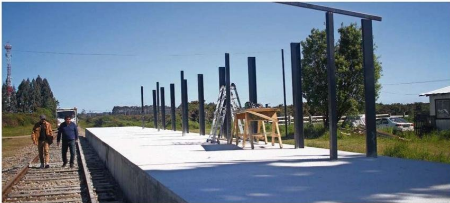
DISTINTOS TRABAJOS SE REALIZAN EN EL PARADERO UBICADO EN ALERCE. TAMBIÉN CONTARÁ CON BUSES DE ACERCAMIENTO.
