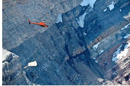
OBRA. El equipo de construcción junto a estudiantes de la Universidad San Sebastián, que llegaron en una expedición y ayudaron con los trabajos. Al lado, el helicóptero de Rotortec llevando uno de los paneles de CLT. En total, transportó 35 mil kilos de materiales.
