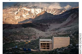
ESPACIO. El refugio tendrá capacidad para hasta 25 personas.
