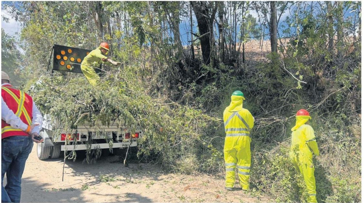
Equipos de Conaf, el MOP, Vialidad, así como de municipios y empresas concesionarias están a cargo de la construcción de cortafuegos en distintos puntos de la región.
