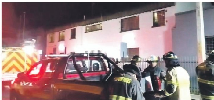
El incendio que afectó al centro de detención preventiva de Ovalle es investigado por Fiscalía y Carabineros.
