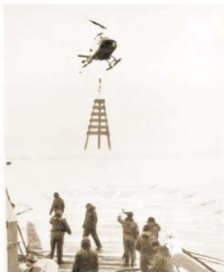
Operaciones aeronavales en apoyo de instalación de Ayudas a la Navegación.
