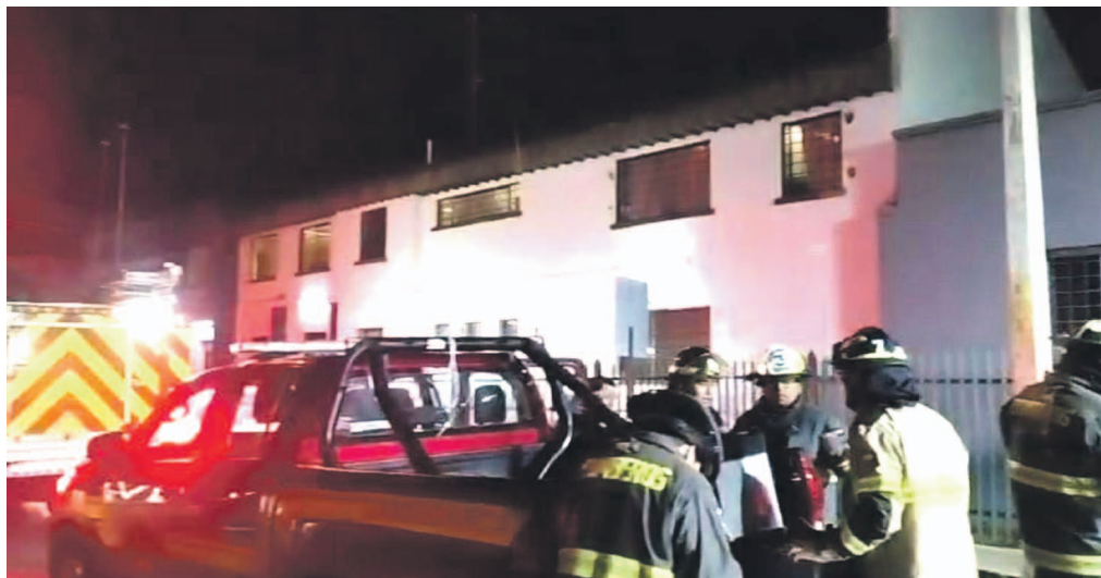
En la noche del jueves se registró un incendio en el Centro de Detención Preventiva de Ovalle.
