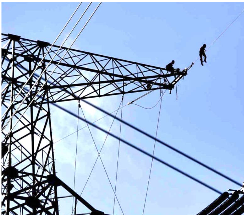
Desde Copelec destacaron que este proceso permitió revelar el valor real de la obra: de US$ 48 a 51 millones.
