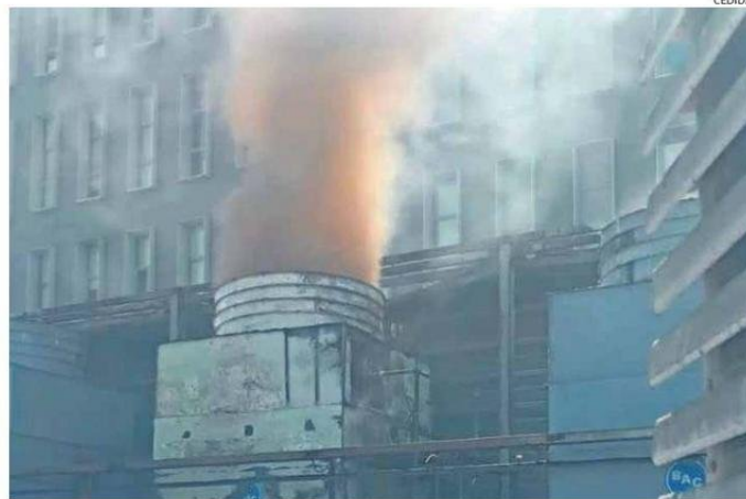
EL SINIESTRO SE GENERÓ EN EL CUARTO PISO EN EL SECTOR DEL EDIFICIO DE LA UNIDAD DE PACIENTE CRÍTICO.
