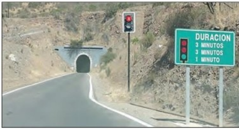
La licitación para construir el Túnel La Grupa II está en proceso y concluirá a fines de noviembre.
