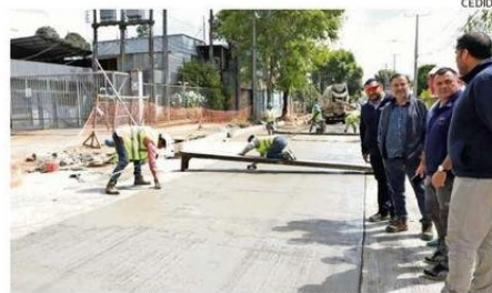
SERVIU INSPECCIONÓ TRABAJOS DE PAVIMENTACIÓN EN 5 DE ABRIL.
