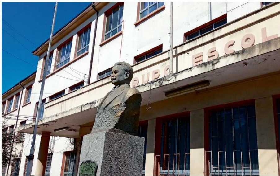
ENTRE LAS INICIATIVAS ESTÁ LA REPARACIÓN DE LA TECHUMBRE DEL GRUPO ESCOLAR DE BARRANCAS.
