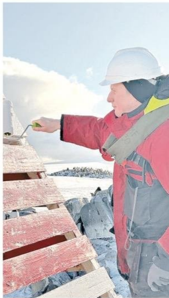
Desde trabajos de pintura y reemplazo de estructuras de ayudas a la navegación son parte de las labores que desarrollan los servidores navales en el continente blanco.
