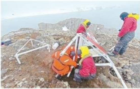
Las complejas condiciones geográficas y meteorológicas van condicionando la construcción de ayudas a la navegación.
