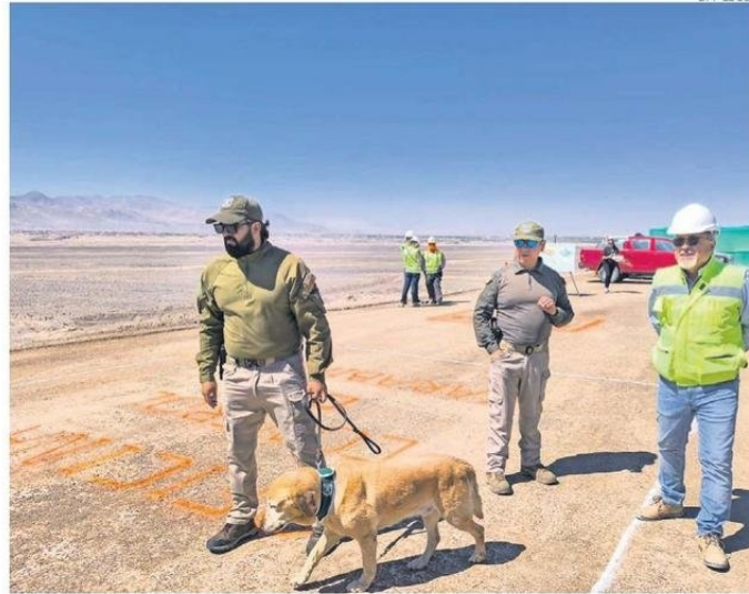
LAS OBRAS DEBERÍAN ESTAR FINALIZADAS EL PRIMER TRIMESTRE DEL 2025 Y HABILITADA PARA FUNCIONAR.
