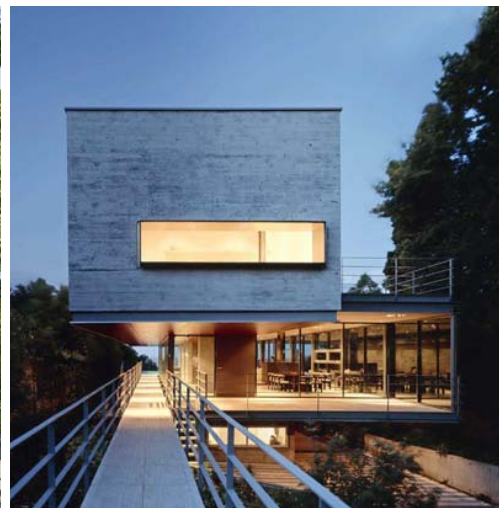
Una estructura desafiante tiene esta obra en Buenos Aires.
