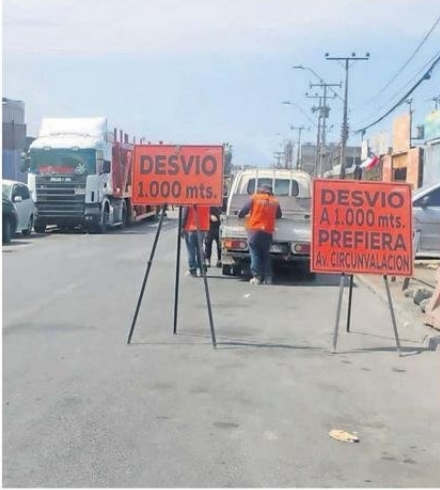
TRABAJOS SON REALIZADOS POR AGUAS DEL ALTIPLANO.
