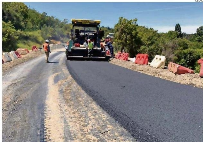
MOP SE ENCUENTRA PAVIMENTANDO 24 RUTAS DE ÑUBLE, LAS QUE SUMARÁN 123 KM A SU RED VIAL.
