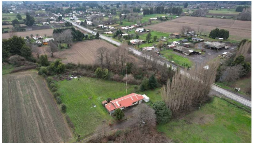
EL CESFAM DE CHACAYAL se emplazará donde, actualmente, funciona la posta de Chacayal Norte.
