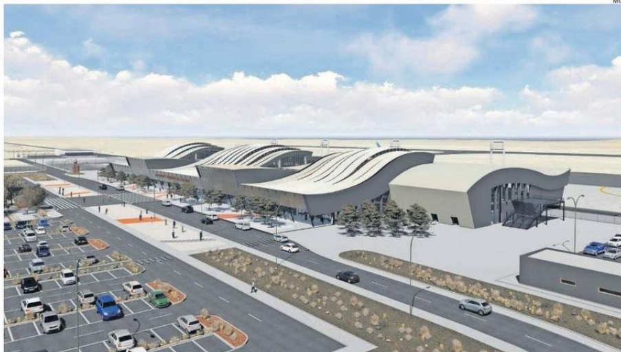
LA PANORÁMICA DEL AEROPUERTO DESIERTO DE ATACAMA.
