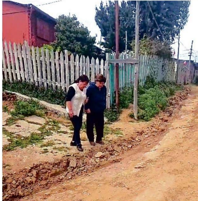
LAS CALLES DE LA PARCELA 20 ESTÁN EN MAL ESTADO.
