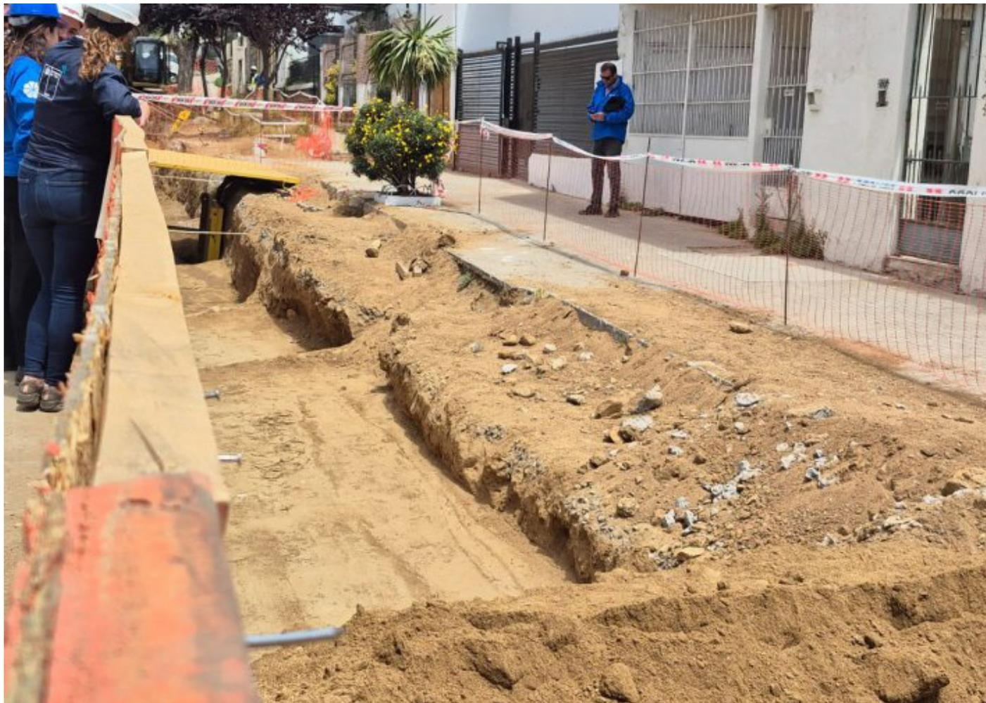
**La Dirección de Obras Hidráulicas del MOP detectó hundimientos en la vía, iniciándose de inmediato la revisión del colector, donde se hallaron problemas estructurales.**
