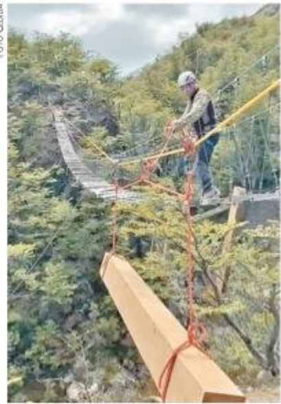
Cinco días antes de lo previsto finalizaron los trabajos de reparación del puente dañado.
