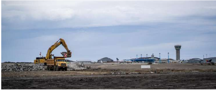
TRABAJOS EN EL AEROPUERTO DE PUNTA ARENAS.
