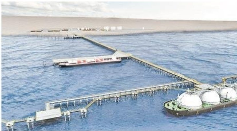
El proyecto integral de HNH Energy contempla la construcción de un puerto multipropósito.
