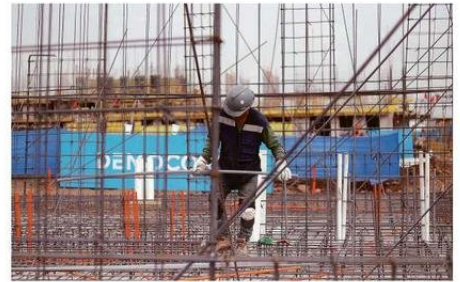
DURANTE SEPTIEMBRE SE AUTORIZÓ EDIFICAR 62.353 M 2 .
