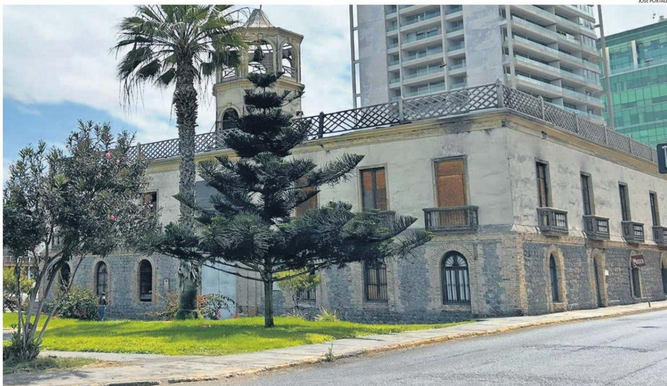
EL 26 DE FEBRERO DE 2015, HACE CASI 10 AÑOS, SE QUEMÓ EL EDIFICIO PATRIMONIAL EL QUE AÚN ESPERA POR SU RESTAURACIÓN.
