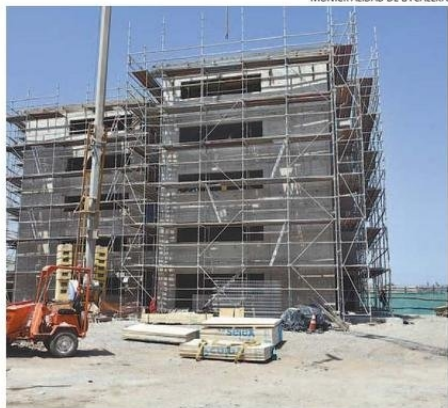
MÁS DE $1.800 MILLONES DE INVERSIÓN TOTAL PRESENTA LA OBRA.
