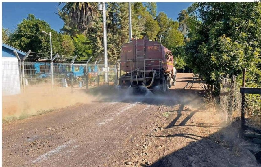
10% DE AVANCE REGISTRA LA APLICACIÓN DE MATAPOLVO EN LA REGIÓN DE ÑUBLE. DURANTE ESTE AÑO SE ESPERA CUBRIR 581 KILÓMETROS.
