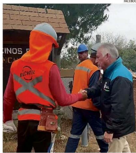
EL ALCALDE VISITÓ LAS OBRAS.
