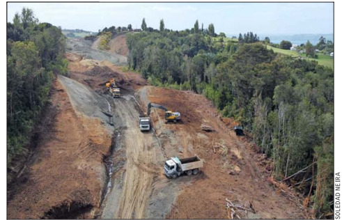
CASTRO.— A casi 9 años del inicio de la obra, frenada dos veces por hallazgos arqueológicos, se reanudaron faenas del baipás, que en un tramo de 16,1 km por la parte alta de Castro sacará la Ruta 5 Sur del centro de la ciudad.
