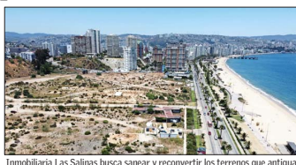
Inmobiliaria Las Salinas busca sanear y recomvertir los terrenos que antiguamente se usaron para almacenar combustibles y petroquímicos.
