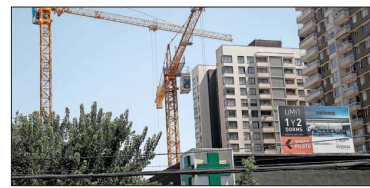
Construcciones de edificios en sectores alrededor de avenida Macul, donde hay varias obras inmobiliarias frenadas.
