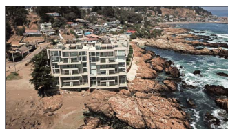
El proyecto inmobiliario Rocas de Maitencillo es un símbolo de los problemas que hubo en la tramitación de una dirección de obras municipales.
