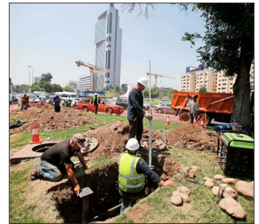
Para las obras, se invertirán cerca de $26 mil millones.
