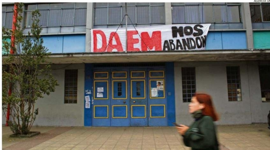
ASÍ AMANECIÓ AYER EL LICEO DE HOMBRES MANUEL MONTT DE PUERTO MONTT, UBICADO EN GUILLERMO GALLARDO.
