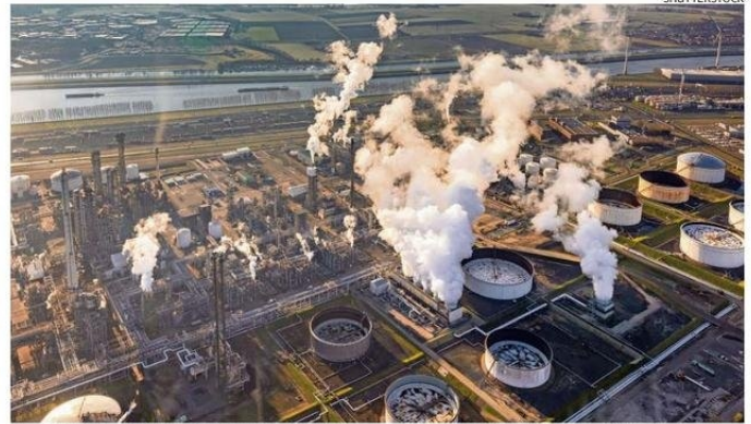
EL CO2 PROCEDE PRINCIPALMENTE DE LA QUEMA DE COMBUSTIBLES FÓSILES Y LA PRODUCCIÓN DE CEMENTO.
