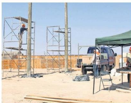
DURANTE LA ETAPA DE CONSTRUCCIÓN.
