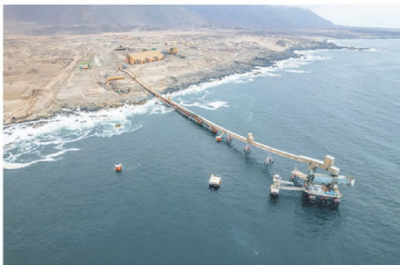
Uno de los proyectos de Transelec para la gran minería: sistema de transporte de agua sin desalar para Minera Centinela.
