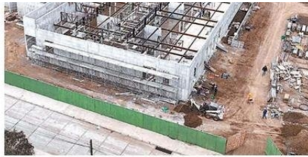
UN 30% DE AVANCE POSEE LA ESTRUCTURA DE CATAPILCO.
