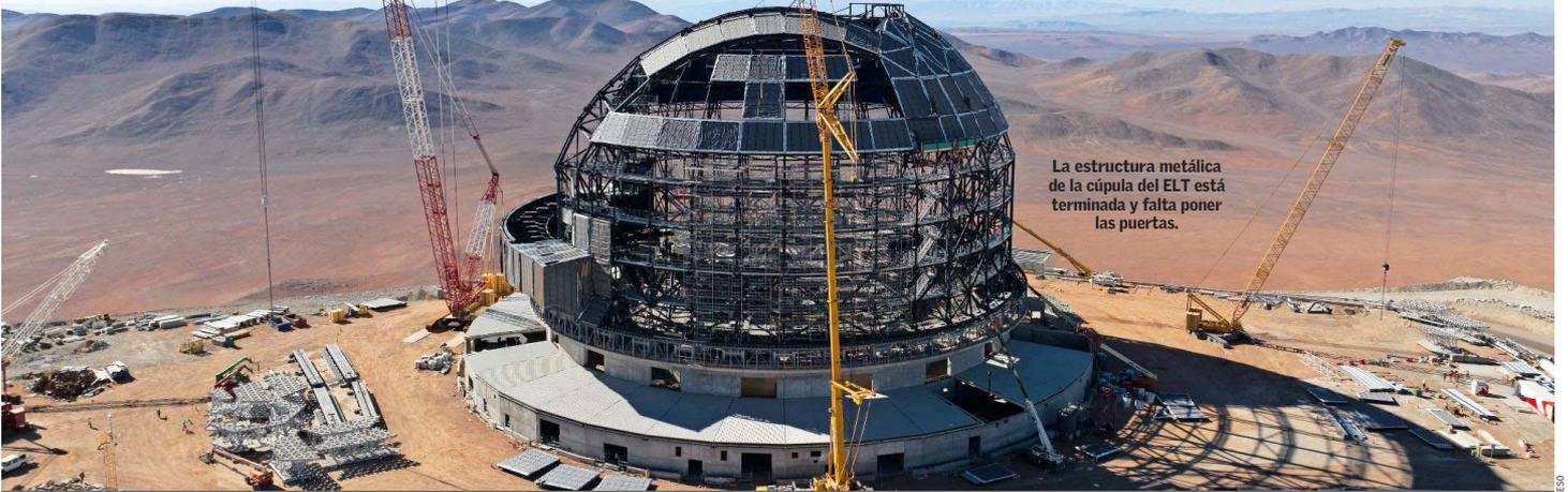
La estructura metálica de la cúpula del ELT está terminada y falta poner las puertas.
