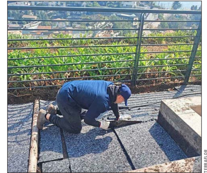
Instalación de placa retenedora de humedad Aquadesk.
