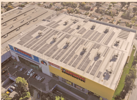
Actualmente, 49 tiendas de Sodimac de Arica a Puerto Montt se abastecen con paneles solares.
