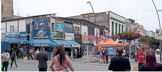
EL INCENDIO DE NOVIEMBRE DE 2019 CONSUMIÓ LA ANTIGUA CRUZ VERDE Y LA ESTRUCTURA SUPERIOR DEL EDIFICIO DE BAQUEDANO. HOY ALBERGA LOCALES COMERCIALES DE DISPOSITIVOS ELECTRÓNICOS.
