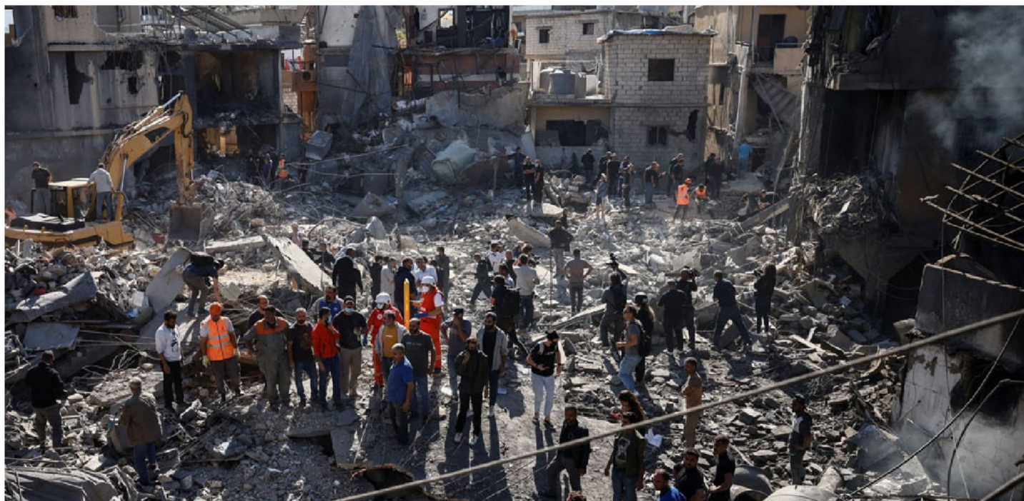
► Trabajadores de emergencia y residentes junto a un edificio demolido después de un ataque israelí cerca del Hospital Rafik Hariri, en Beirut, Líbano, el 22 de octubre de 2024.
