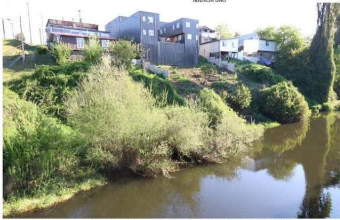
LA FALTA DE ALCANTARILLADO SE ARRASTRA POR AÑOS EN EL SECTOR DE LA CALLE SANTA MARÍA.
