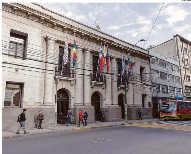
ASOCIACIÓN DE FUNCIONARIOS SEÑALA QUE VAN ONCE CASOS EN LA MISMA UNIDAD.
