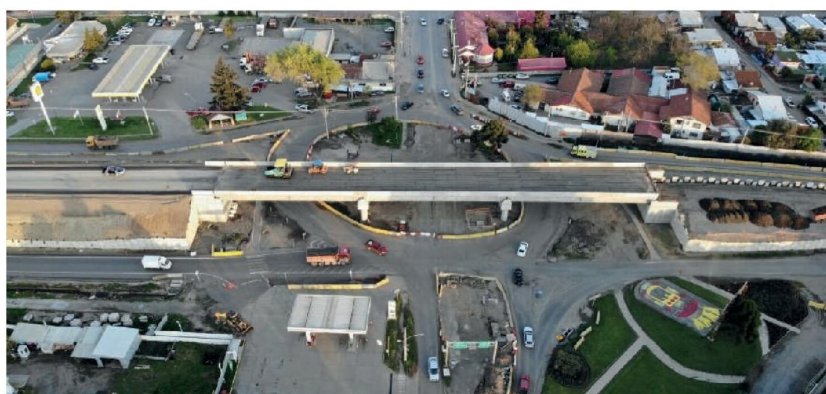
EL ENLACE HUEQUÉN, en la entrada de Angol, las obras ya están prácticamente terminadas.
